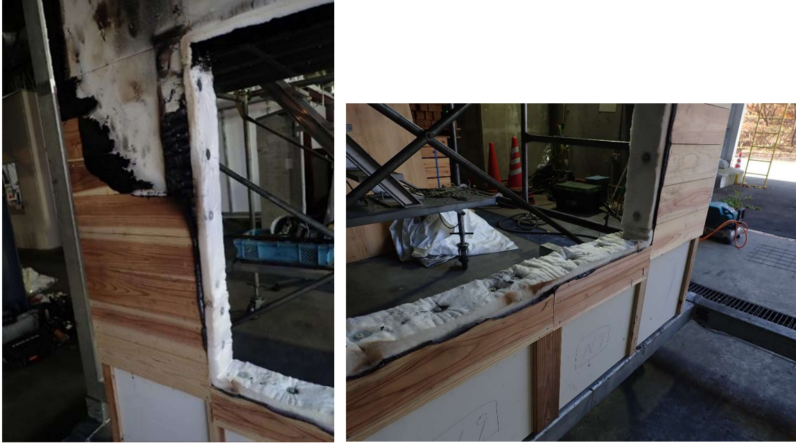
写真 2.3-6 試験後の開口部周囲の様子（試験体 N(9)）
